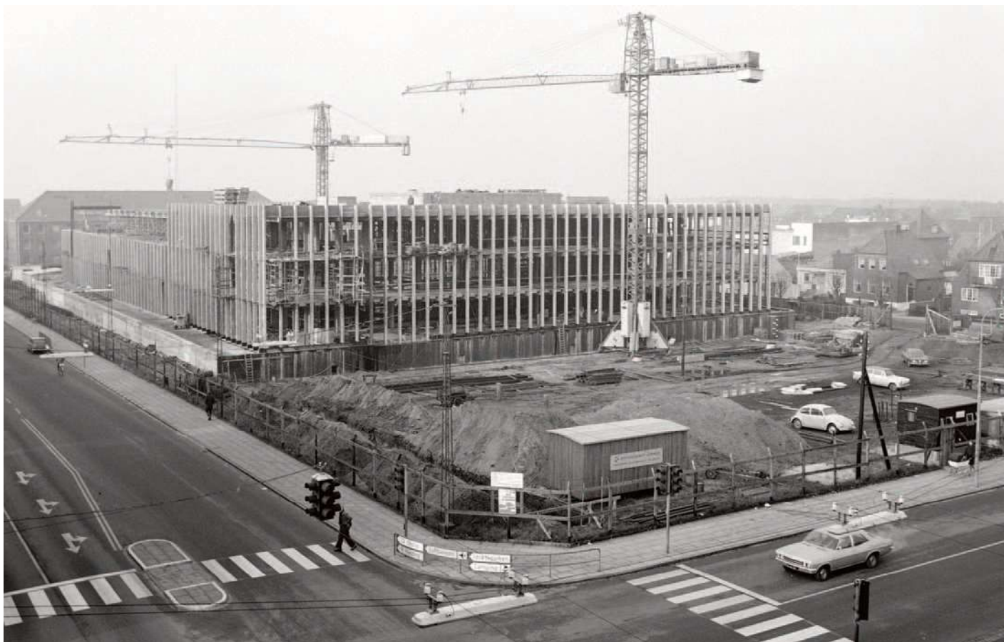
Murermester Frederik Skærbæk havde murerentreprisen på Esbjergs nye Rådhus i Torvegade 74. Rådhuset, som her ses under opførelse, blev indviet 1. oktober 1970. Foto: Peter Nissen. EBA 14254-042.
