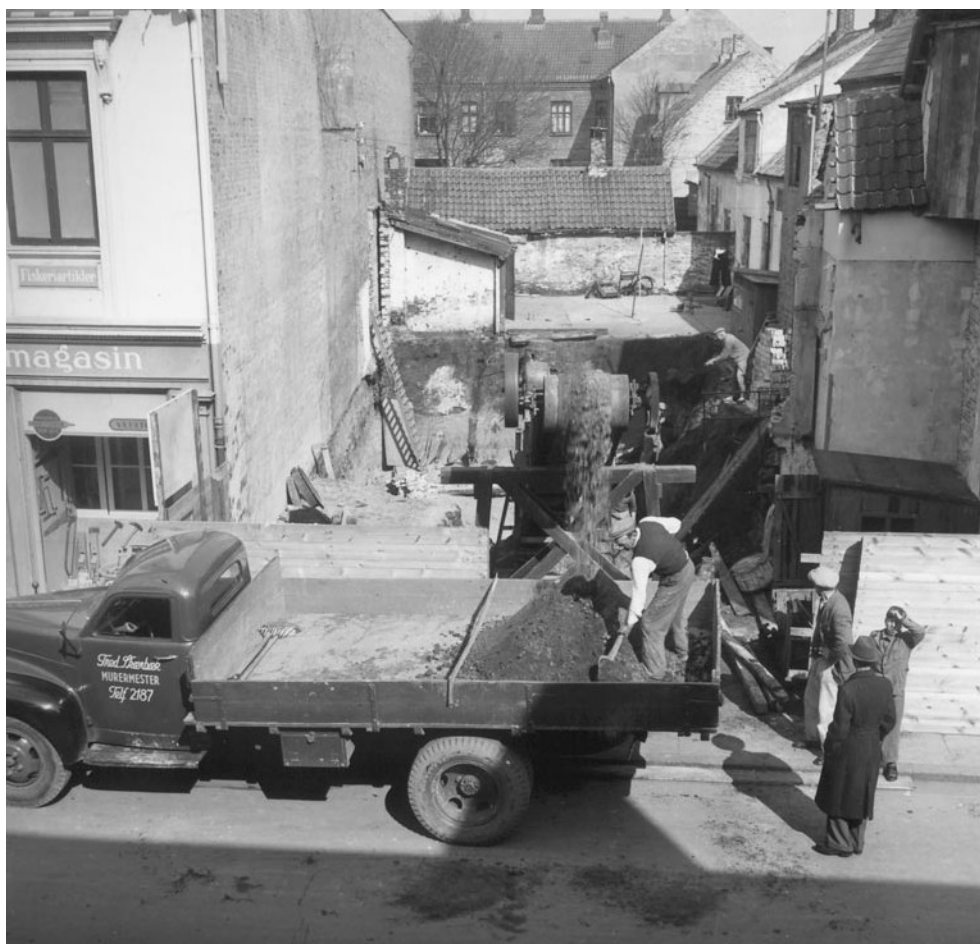
Murermester Skærbæks personale i gang med byggeri ved siden af læderhandler Nordahl, Kongsgade 67, 1948. Foto: Paul Bølling. EBA 54064-008.
